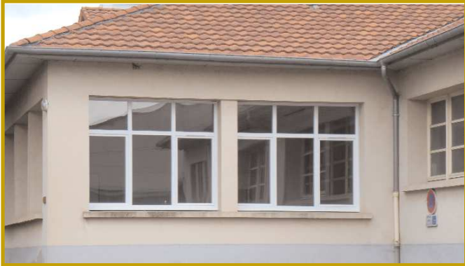
Travaux d'isolation sur le bureau de vote à La Madeleine.
