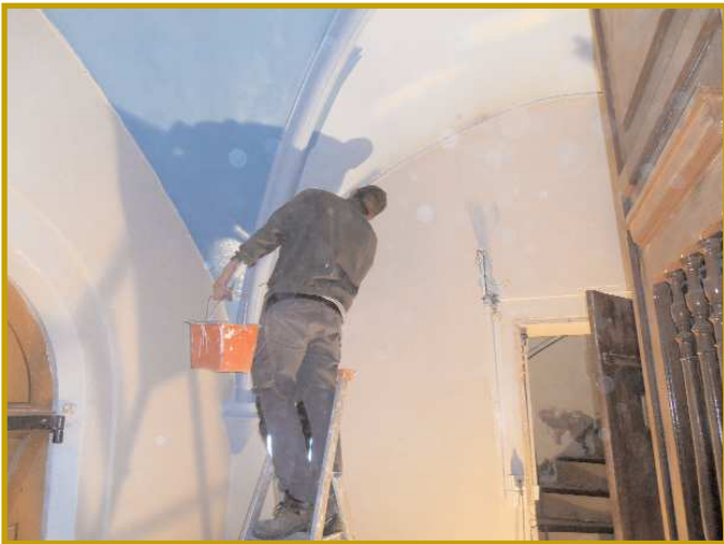
Remise en peinture des murs de l'église et changement de la chaudière.
