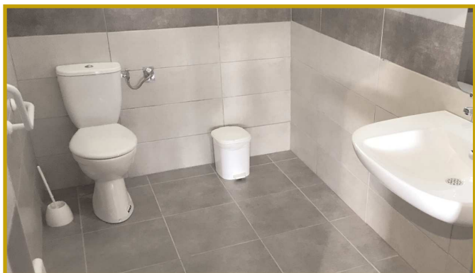
Création d'un WC handicapé à l'école de Montaigu.
