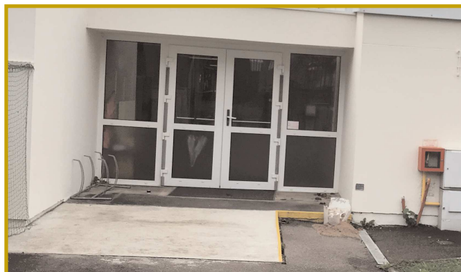
Peinture de la façade et porte d'accès ADAP maternelle Montaigu.
