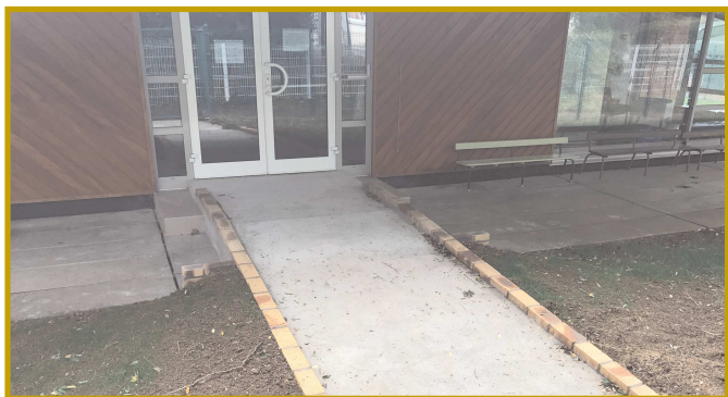
Création d'une rampe pour handicapés à la halte-garderie.
