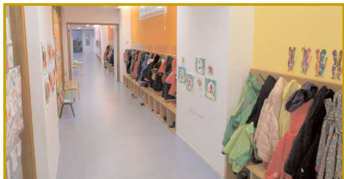
Peinture d'un couloir à l'école des 5 Fontaines.
