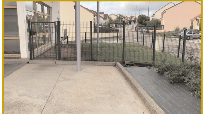
Remplacement du grillage extérieur sur le groupe scolaire des 5 Fontaines.
