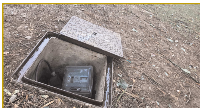
Installation de prises électriques dans le parc de la M.J.C.
