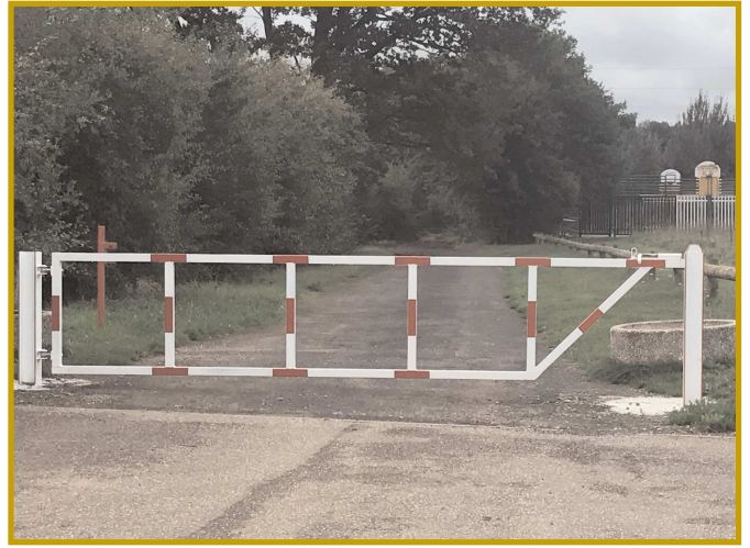
Pose d'une barrière de sécurité près du City Stade du site des 5 Fontaines.
