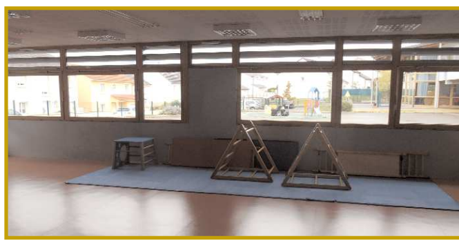
Remplacement des vitrages de la salle d'évolution 5 Fontaines.
