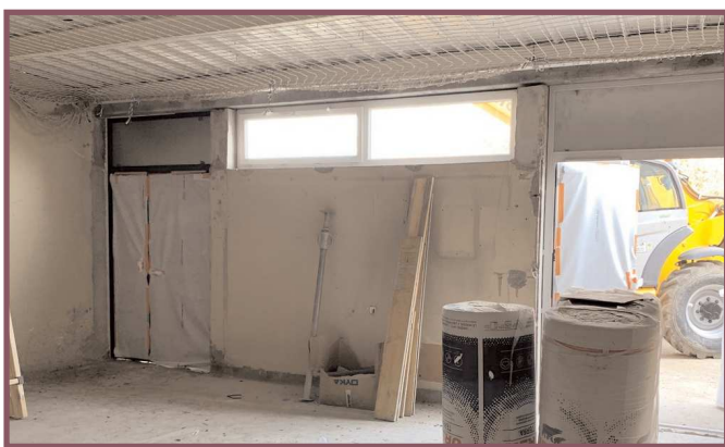
La SALLE des SPORTS : la toiture sera entièrement refaite, dès à présent une partie est faite et ainsi les plaquistes peuvent commencer les travaux à l'intérieur, la chaufferie est terminée.
