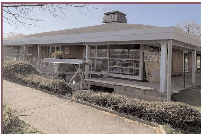
Le toit de la HALTE GARDERIE : Il est maintenant terminé, nos petits sont à l'abri et en sécurité.
