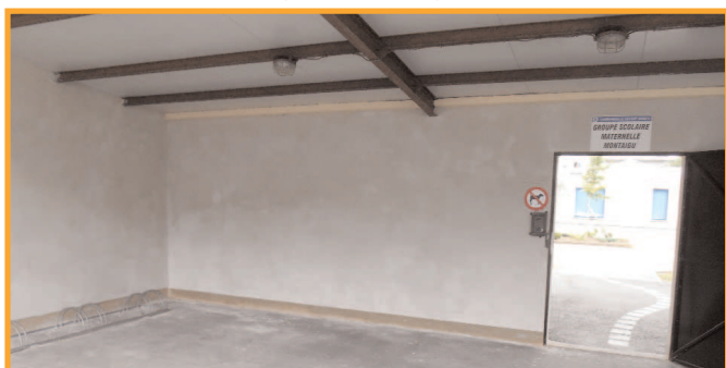
Réfection du crépi du préau de l'école maternelle
