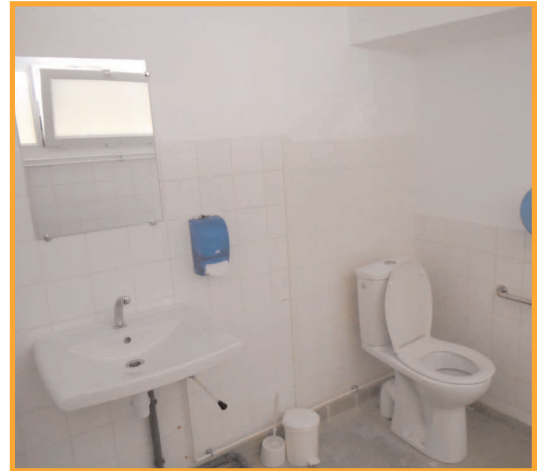
Création d'un WC handicapés
