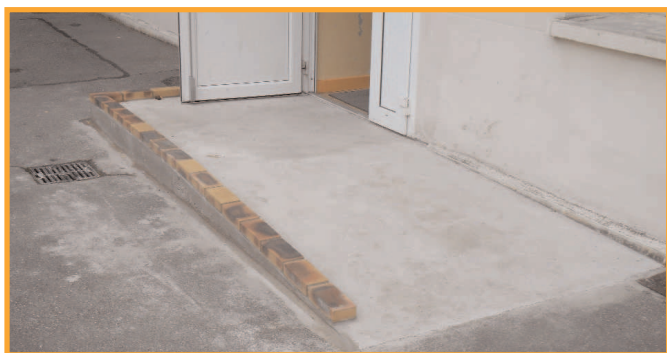
Création d'une rampe pour accès handicapés
