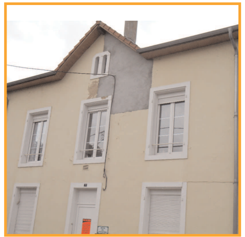
Reprise du crépi sur la maison des associations puis remise en peinture
