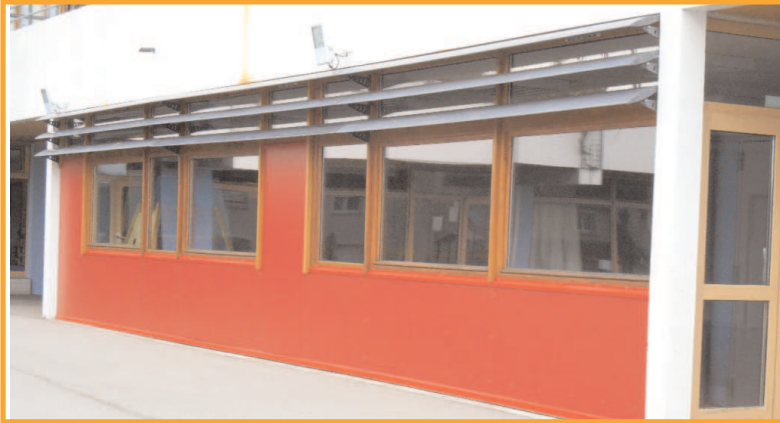
Reprise du soubassement de la salle d'évolution et mise en lasure
