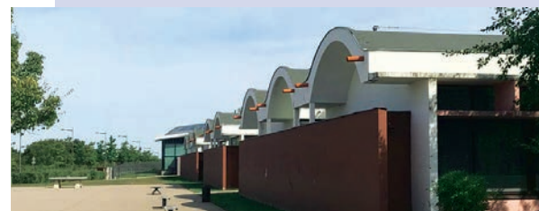
COLLÈGE MONTAIGU situé au 1 rue du collège à Heillecourt
